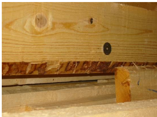
Image 1. La flache sur le bord de la planche n'est pas réglementée.
